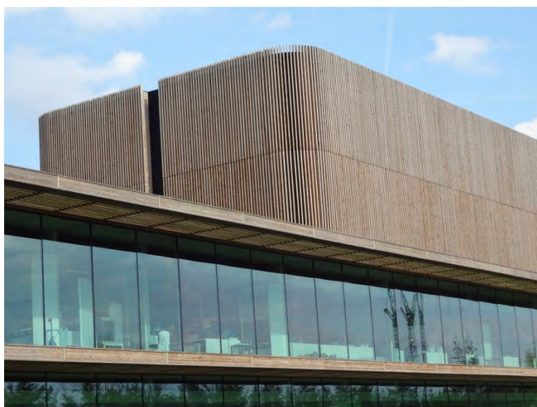
Figuur 3: Het NIOO-gebouw in Wageningen met gemodificeerd houten gevelbekleding
