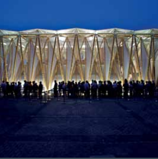
Versterkt bamboe als bouw materiaal in het Duitse paviljoen op de Expo Shanghai in 2010.
